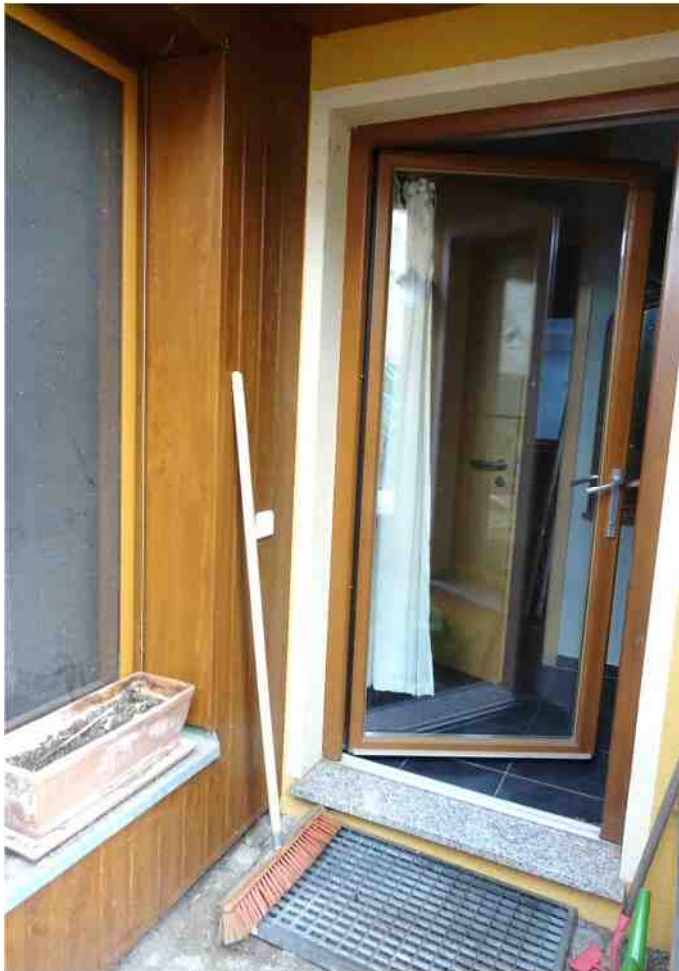
KIRCHSTRASSE 2, WERDER (HAVEL) Eingangssituation des Hauses im EG
