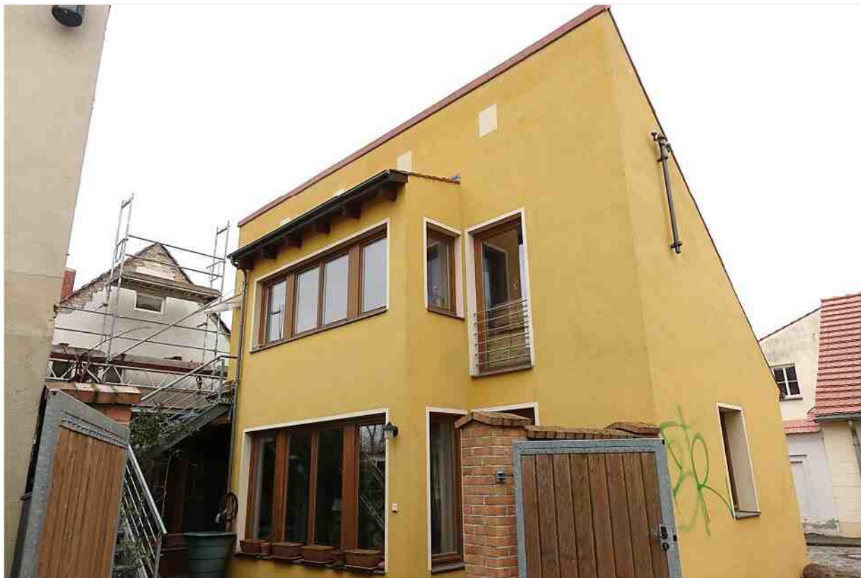
KIRCHSTRASSE 2, WERDER (HAVEL) Hofseitige Ansicht, Südwestfassade
