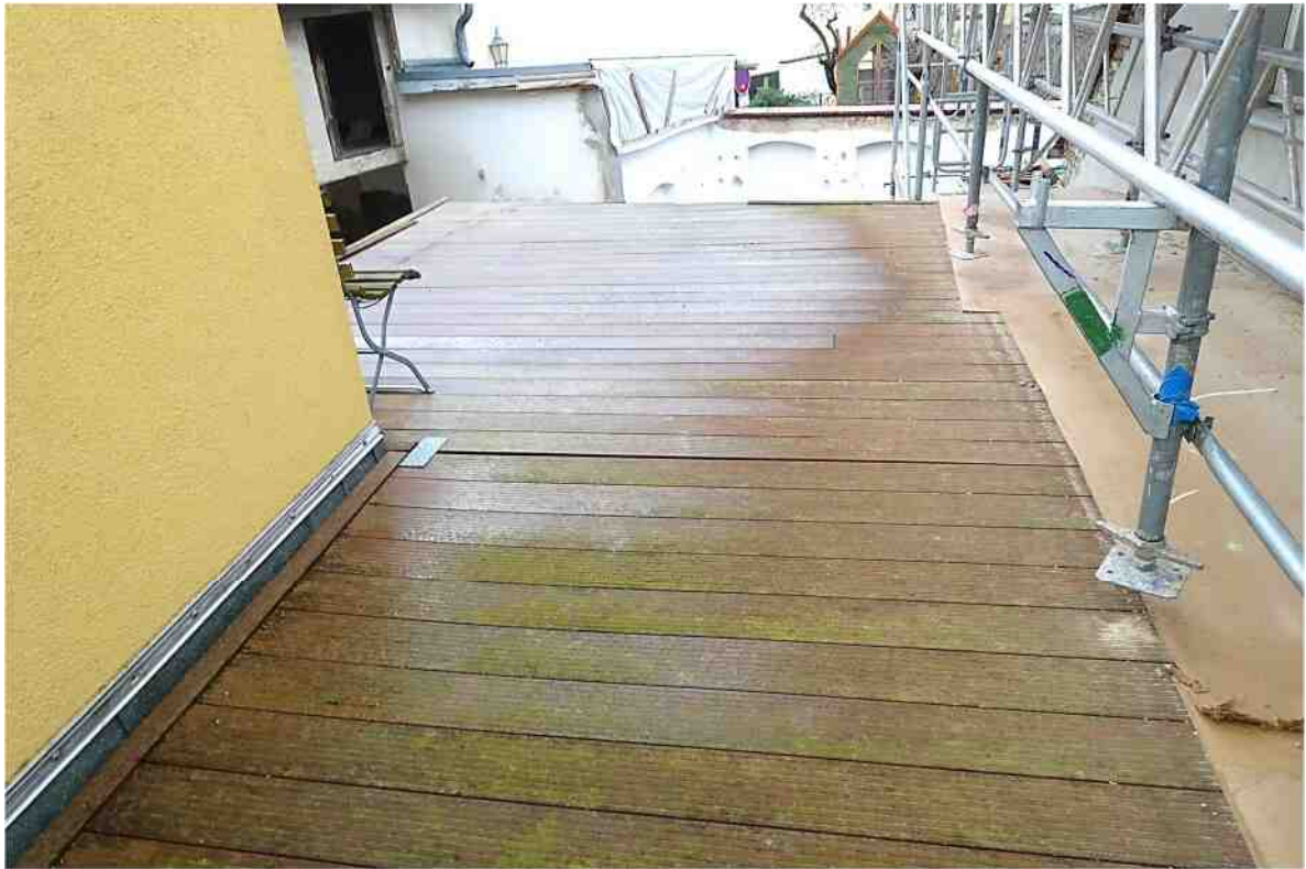
KIRCHSTRASSE 2, WERDER (HADEL) Holzterrasse zum DG
